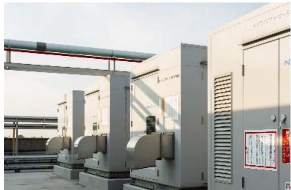
【関東工場フリーザー用冷凍機】
